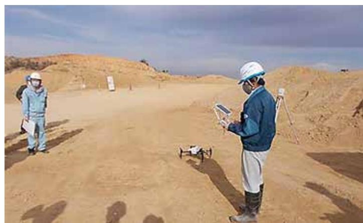
・ドローンでの測量：従来なら、光波・レベルなどの機械で、平面・横断・縦断を測量して土量を計算していくが、今は、ドローンを使った測量が主流となりつつある。
